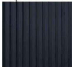
Bardage métallique vertical foncé
