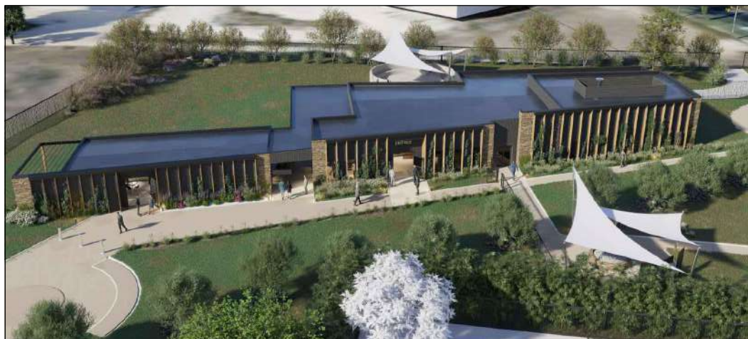
Vue des toitures et jardins
